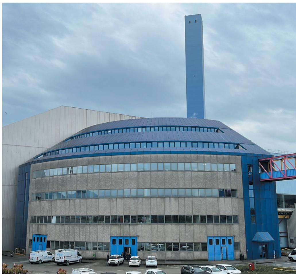
progetto di “flue gas cleaning”: un investimento di circa 110 milioni di euro per rendere il termoutilizzatore ancora più efficiente e sostenibile. Grazie a una tecnologia innovativa è stato possibile generare energia termica in più per 12.500 famiglie a parità di rifiuti trattati, riducendo così l'uso del gas per alimentare la rete del teleriscaldamento e portando il rendimento dell'impianto vicino al 100% (dall'84% al 98%).
